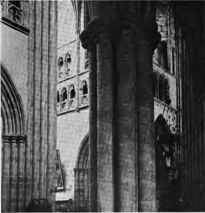
Fig. 114. — Galerie intérieure de circulation à deux étages dans le chœur et le transept de l'ancienne cathédrale de Tréguier.
